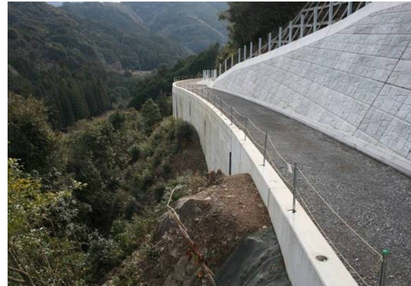
右岸下流付替市道
