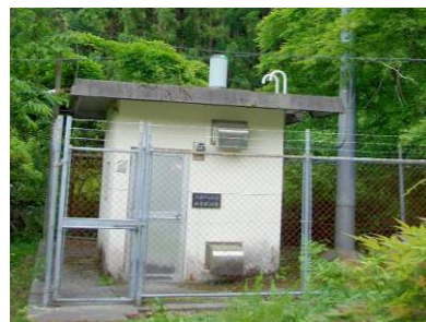
雨量観測所(他ダム事例)
