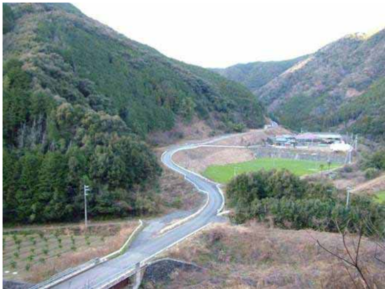
右岸下流付替市道
