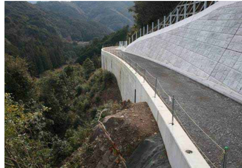
右岸下流付替市道
