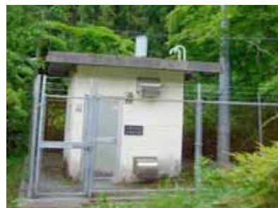
雨量観測所(他ダム事例)
