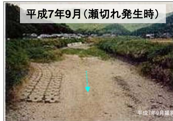
横瀬川(ヒエダロ橋付近)瀬切れ状況
