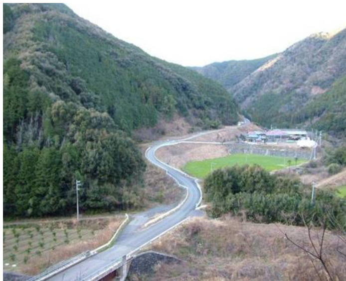
右岸下流付替市道
