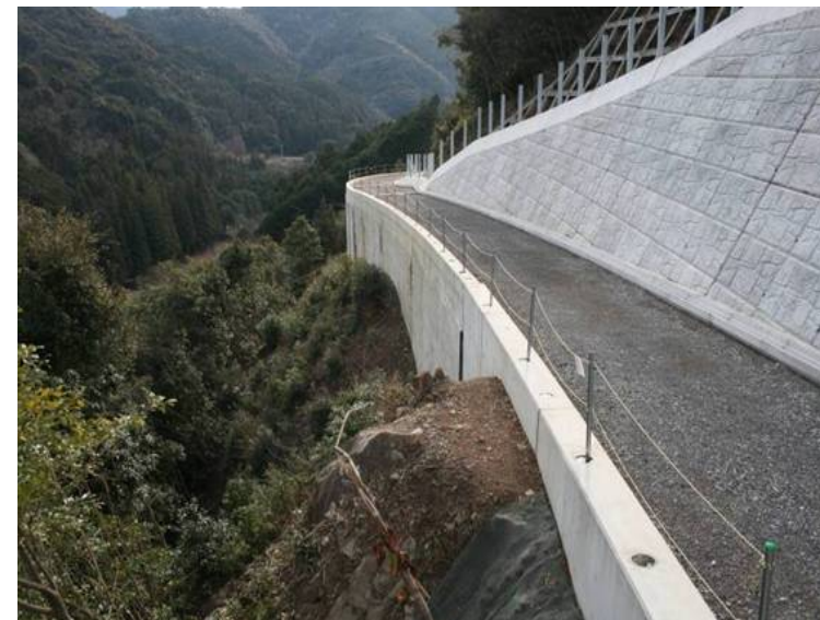
右岸下流付替市道
