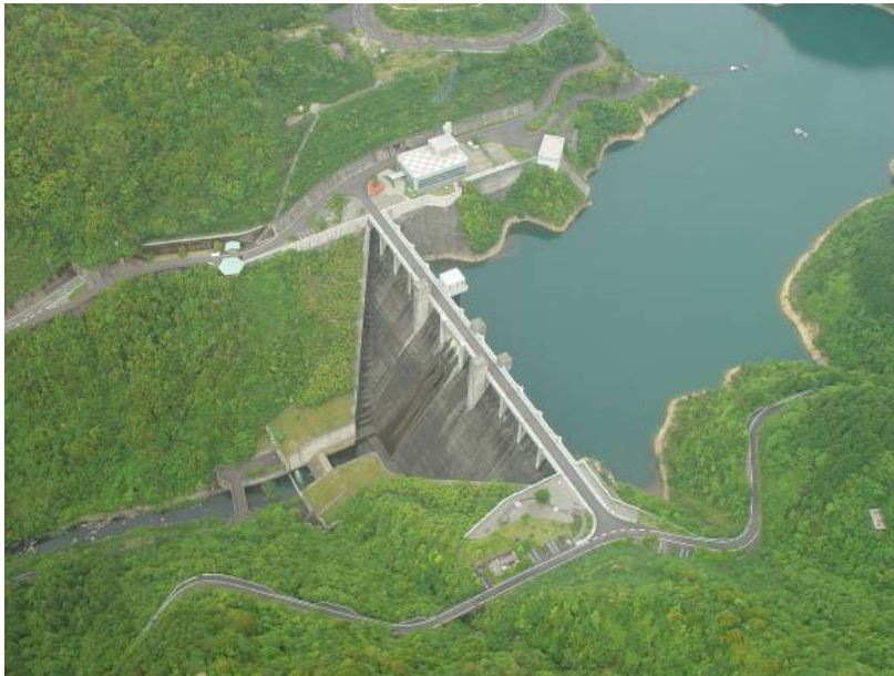
中筋川ダム(平成10年度完成)
