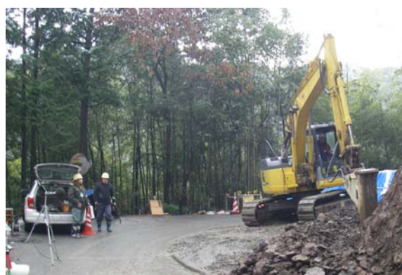
写真 3.2.5 騒音測定の実施
