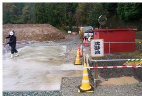
写真 3.2.6 沈砂池の設置
