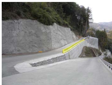
写真 3.2.2 下敷水地区工事用道路
