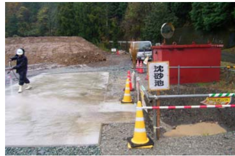
写真 3.2.6 沈砂池の設置
