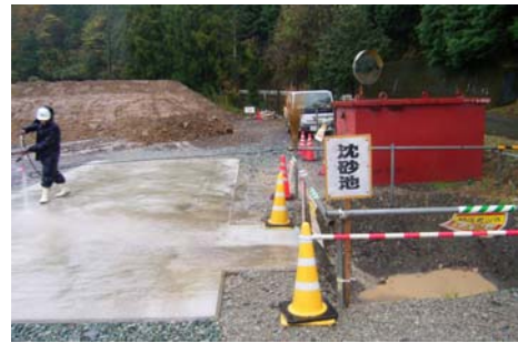
写真 3.2.6 沈砂池の設置
