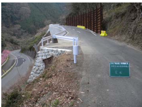
写真 3.2.1 月野尾地区工事用道路
