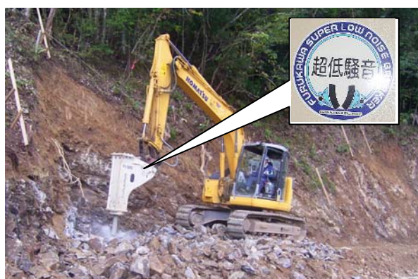
写真 3.2.4 低騒音型建設機械の使用
