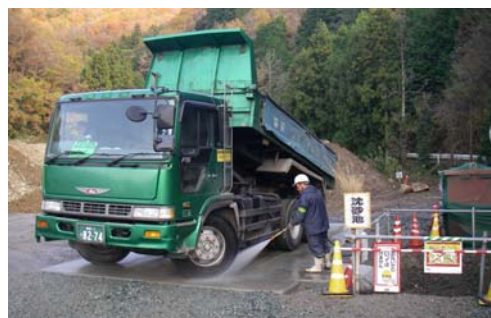
写真 3.2.3 工事用車両のタイヤ洗浄
