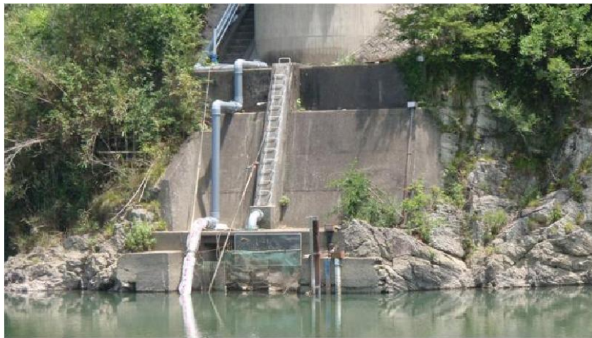
写真 2.2.13 渇水による水位低下時の取水塔の状況
