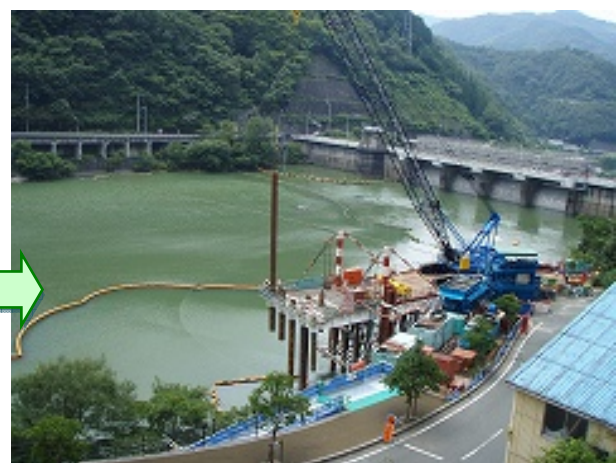
曝気循環施設稼働によりアオコが概ね消滅した状況
