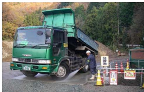
写真 3.2.3 工事用車両のタイヤ洗浄
