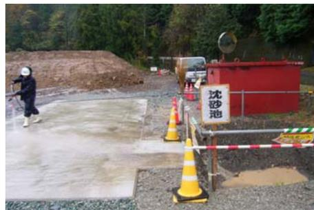
写真 3.2.6 沈砂池の設置
