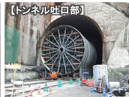
平成27年9月末 (放流管トンネル坑内搬入)
