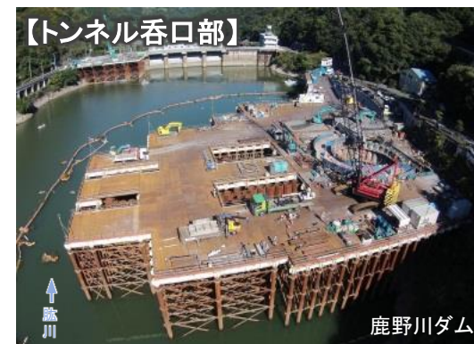
平成27年9月末 (底盤コンクリート養生)
