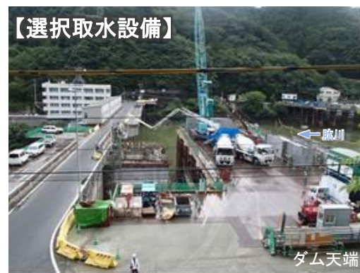
平成27年9月末 (新設取水塔基礎構築)
