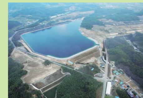
写真提供：水資源機構香川用水総合事務所(平成20年11月15日撮影)
