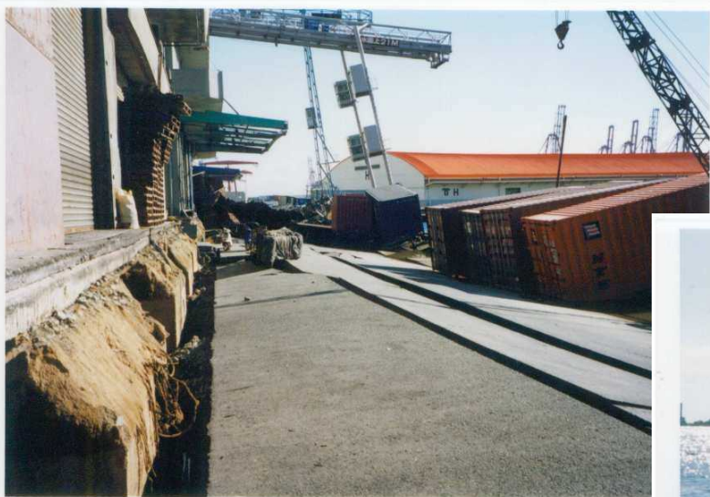
麻耶埠頭 第一～第二突堤間
