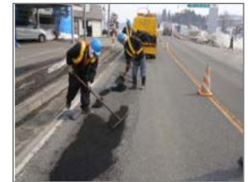
舗装版舗設作業
