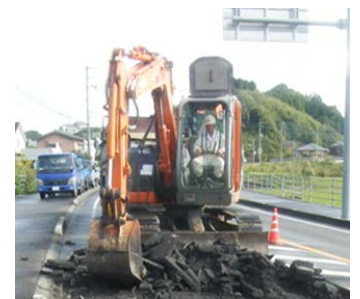
舗装版破碎作業
