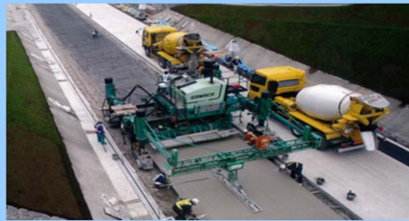
新規制定工種 (連続鉄筋コンクリート舗装工)
