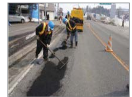
舗装版舗設作業
