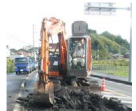
舗装版破砕作業
