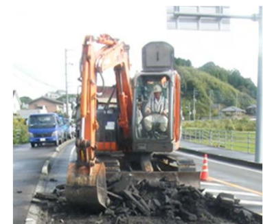
舗装版破碎作業
