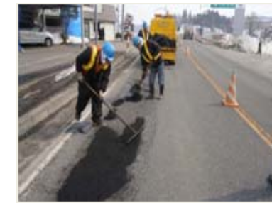
舗装版舗設作業
