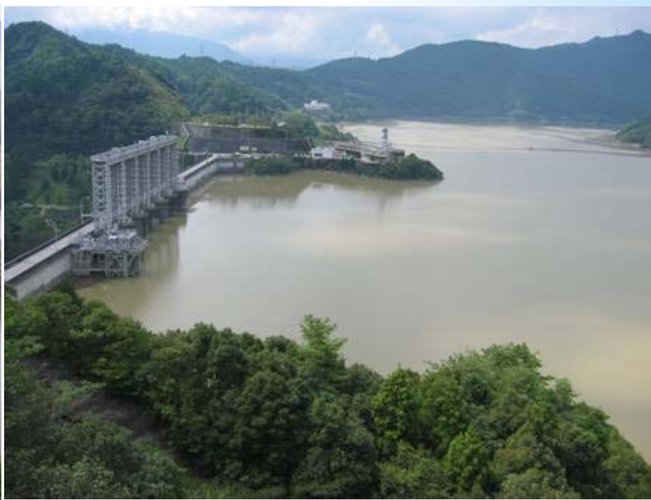
洪水調節後の早明浦ダム (H17. 9. 7 9時頃) 貯水率100%
