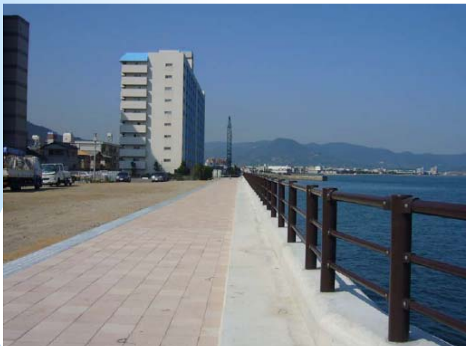
高松港海岸 護岸改良 (サンポート地区)
