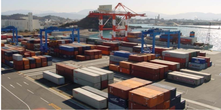
港湾施設の整備
