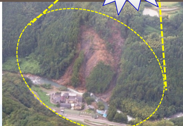
鏡的淵(高知) 台風11号 法面崩壊
