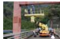
【主塔の近接目視】
