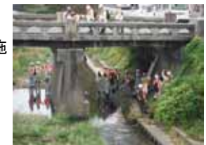
橋梁フィールドワーク状況
