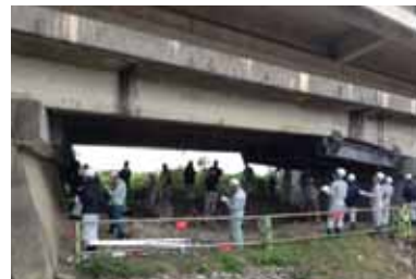
ゲルバー橋の損傷点検
