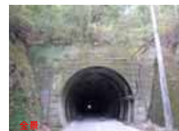
▲松尾隧道(完成後63年経過)
