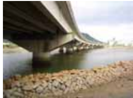
▲屋島大橋(完成後32年経過)
