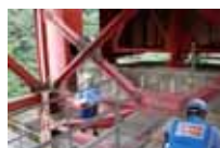
【補剛桁の近接目視】
