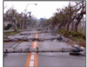
(台風による道路の被災状況)
