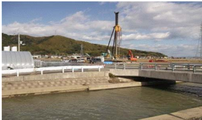
施工着手状況
