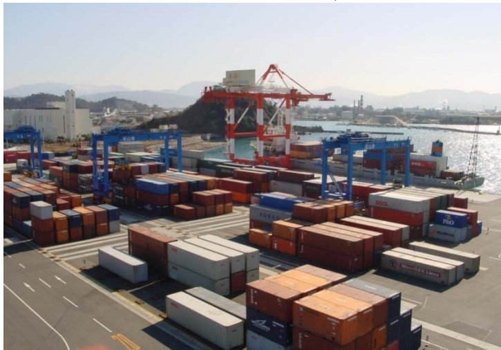
松山港外港地区岸壁(-10m)でのコンテナ荷役作業
