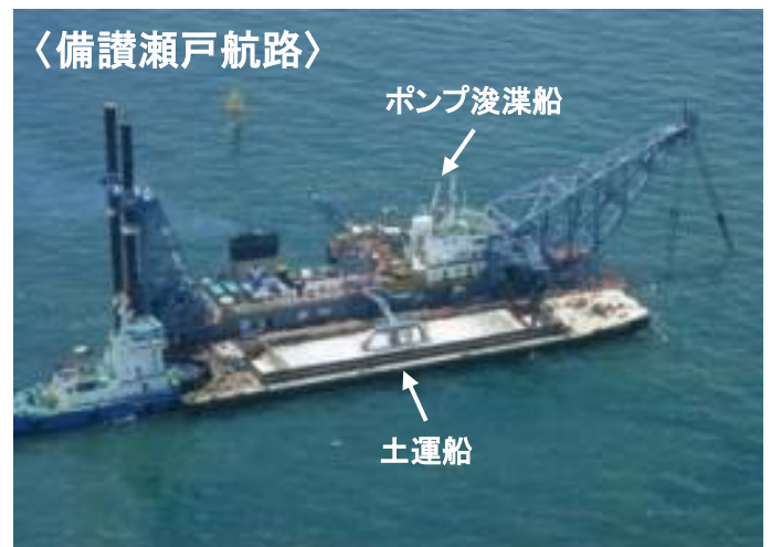
■航路の埋没に対し、浚渫工事により必要水深を維持
