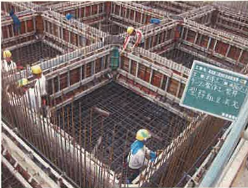
型枠組立状況(隔室)
