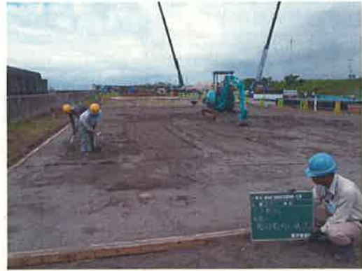
砂の敷均し状況
