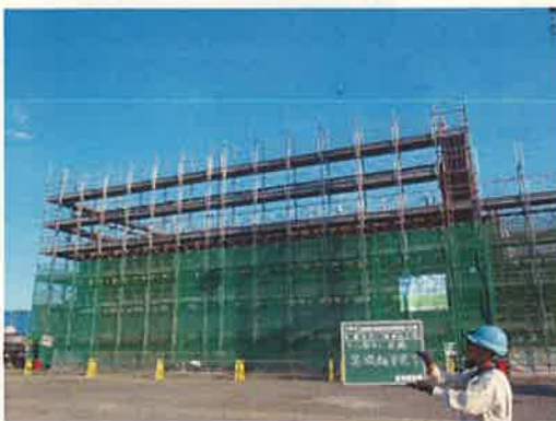
足場組立完了
