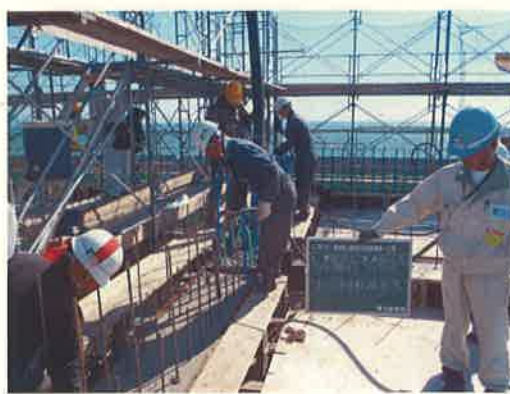
コンクリート締固め状況
