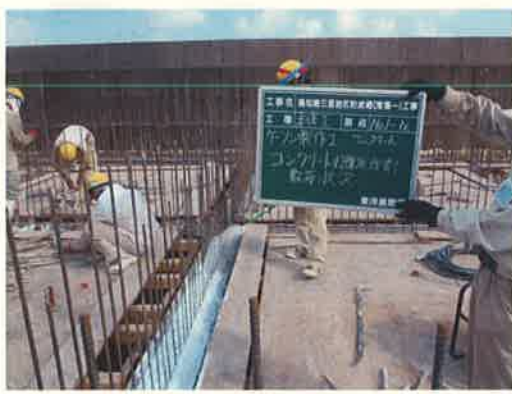
コンクリート打継処理剤散布状況
