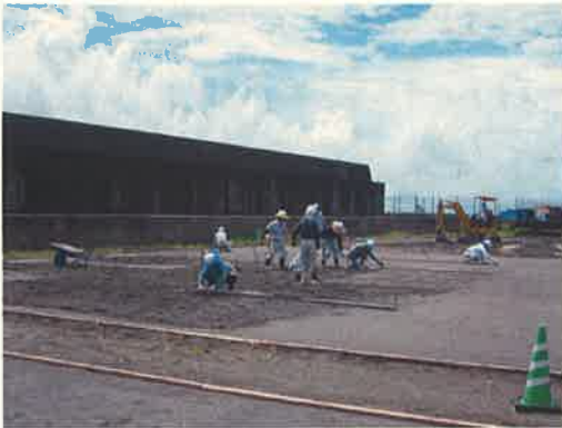
砂の敷均し状況(仕上げ)
