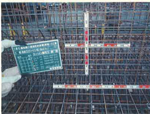
鉄筋組立確認
