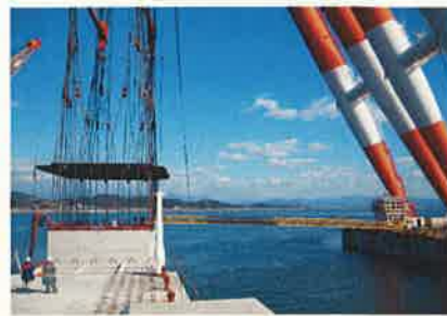
ケーソン据付
