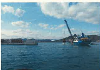
基礎捨石投入
