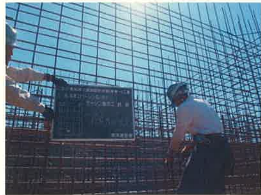
鉄筋組立完了(人通孔復旧)
