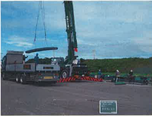
鉄筋搬入状況
