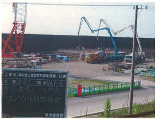
コンクリート打設状況
