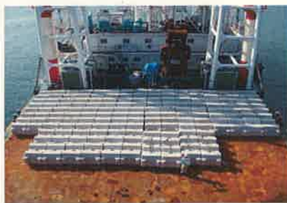
被覆ブロック積込
