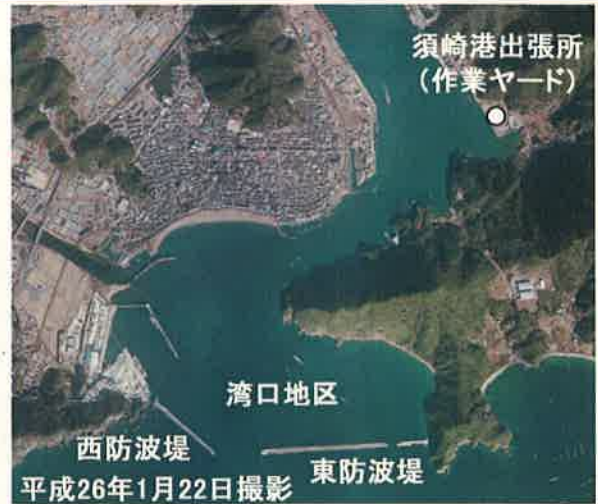
防波堤全体でケーソン60函 本体ブロック116個据付
