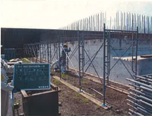
足場組立状況
