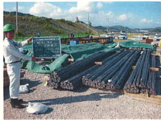
鉄筋確認状況
