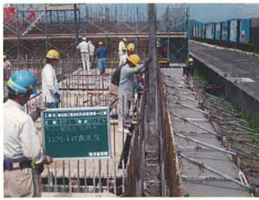
コンクリート打設状況
