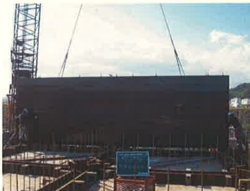
型枠組立状況(側壁)
