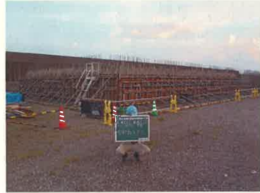
型枠組立完了(1ロット)
