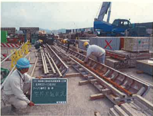
型枠大組状況(1ロット)
