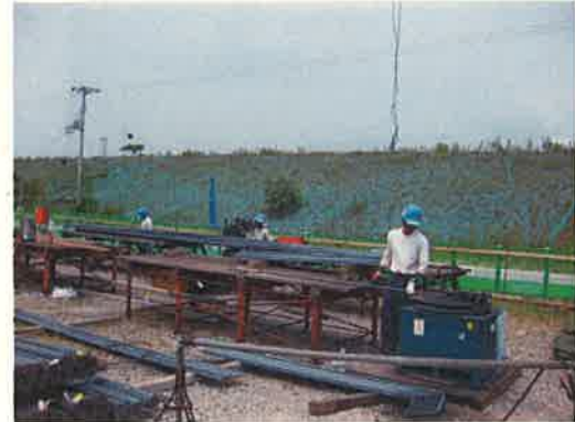
鉄筋加工状況
