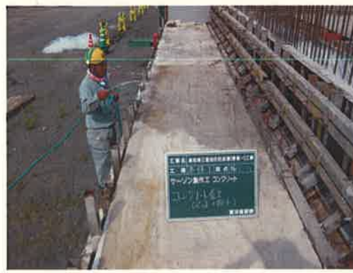
コンクリート養生
