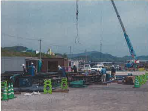
鉄筋加工状況
