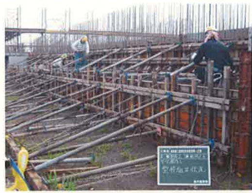
型枠組立状況
