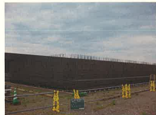
鉄筋組立完了(1ロット)
