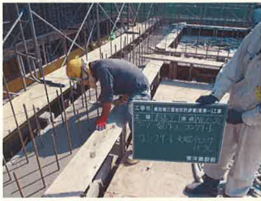
コンクリート天端仕上げ状況
