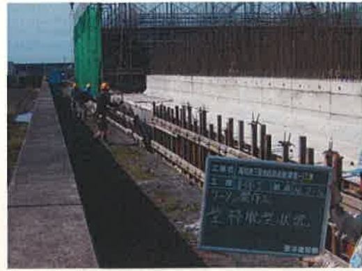
型枠脱型状況(フーチング)
