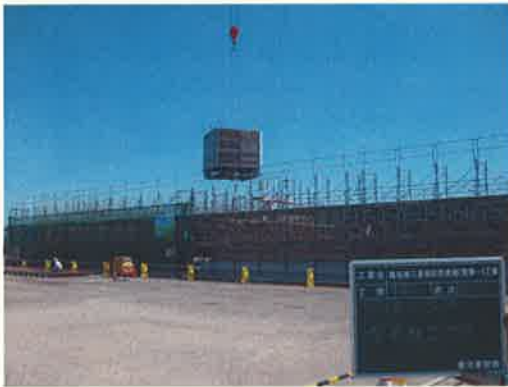
型枠組立状況(隔室)
