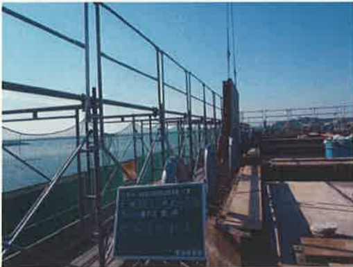
型枠脱型状況
