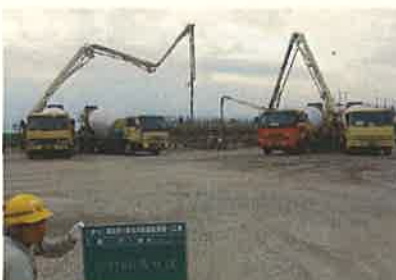
コンクリート打設
