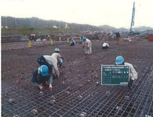
鉄筋組立状況(底版)
