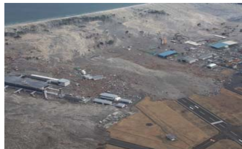
(東日本大震災における津波による甚大な被害)
