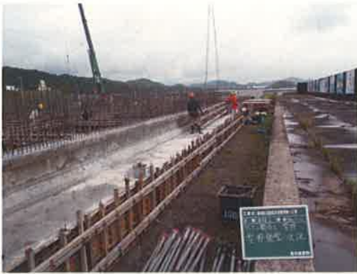
型枠脱型状況(側壁)
