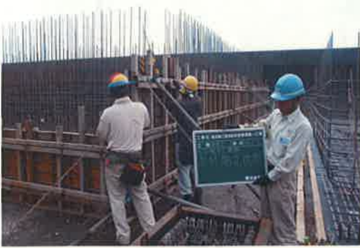
型枠組立状況
