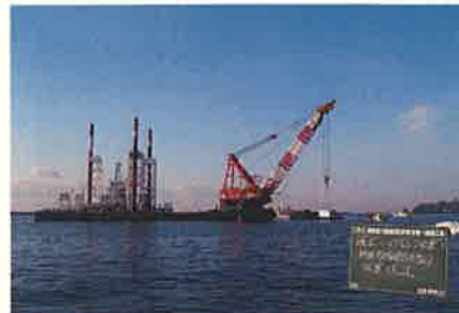
根固ブロック 据付・仮置
