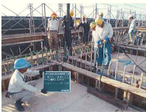
モルタル敷均し状況
