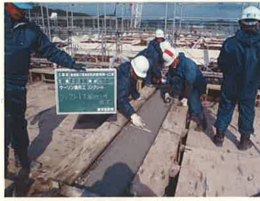
コンクリート天端仕上げ状況(5ロット)
