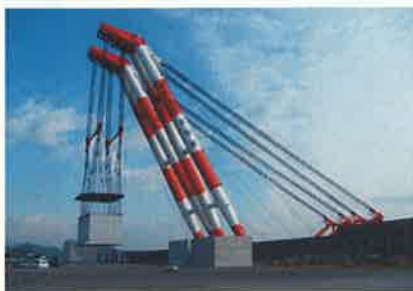
ケーソン吊上げ
