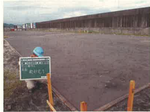
函台製作完了
