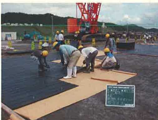
路盤紙・マット敷設状況
