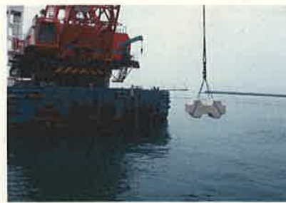
被覆ブロック据付
