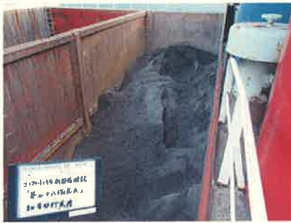
細骨材貯蔵状況
