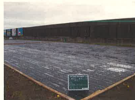
摩擦増大マット敷設完了
