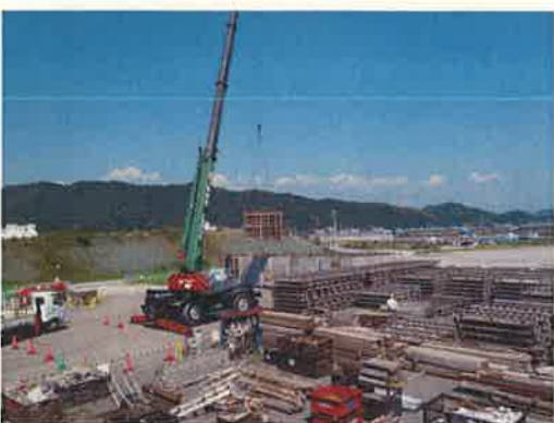
型枠大組状況
