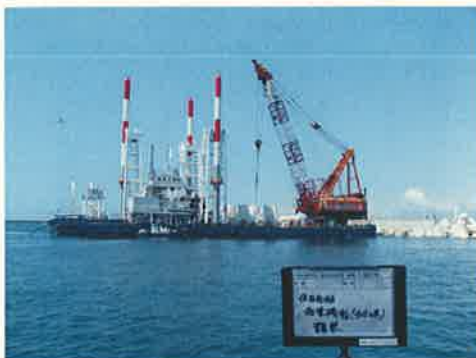
起重機船(415t吊)
