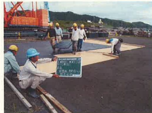
路盤紙・マット敷設状況
