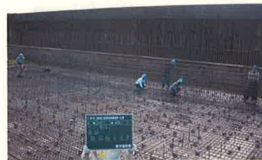
鉄筋組立状況
