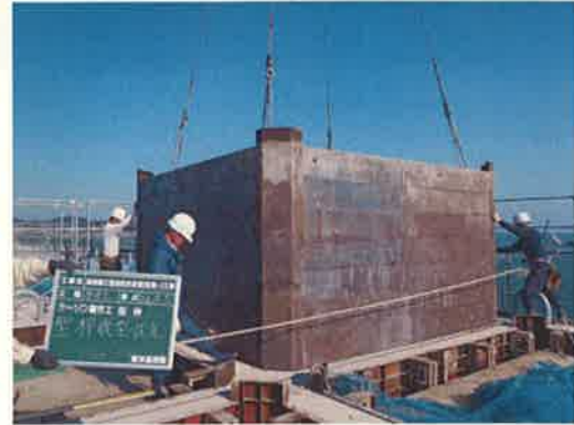
型枠脱型状況(隔室)
