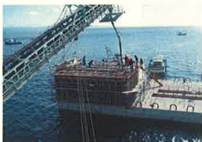
上部工 コンクリート打設
