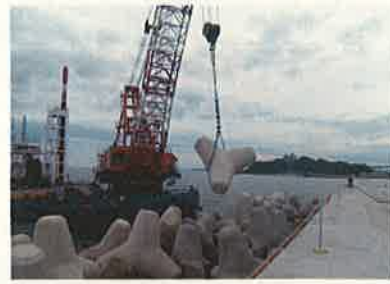
消波ブロック据付
