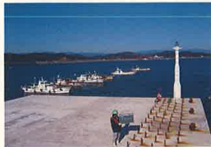
捨石均し(海上の状況)
