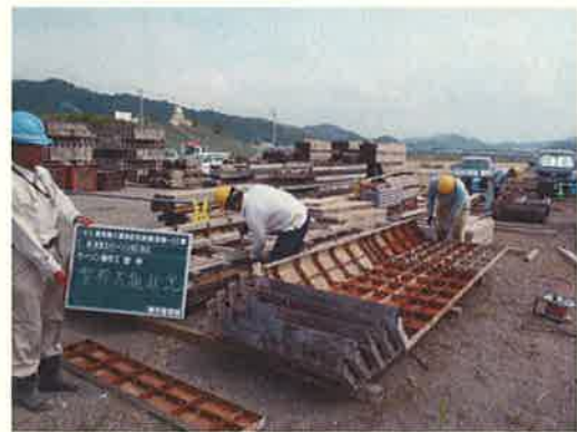
型枠大組状況(1ロット)
