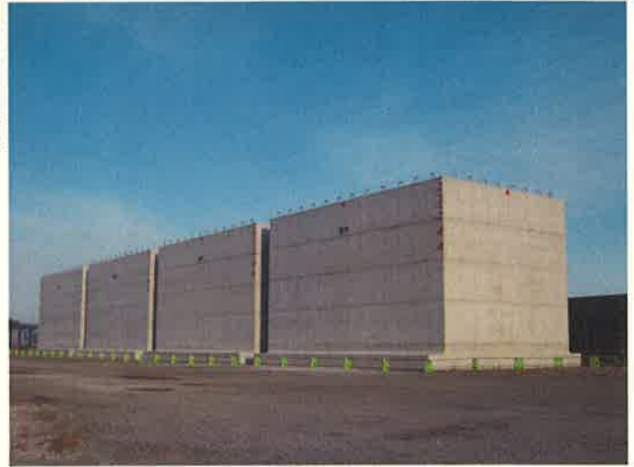
ケーソン完成
