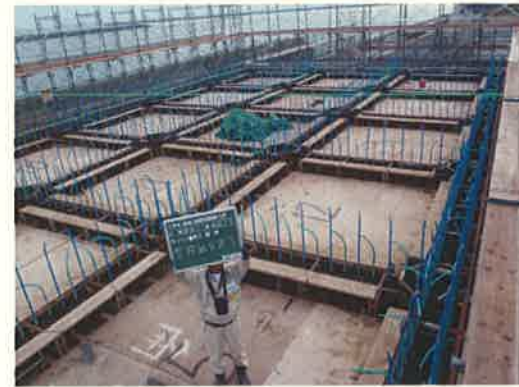
型枠組立完了
