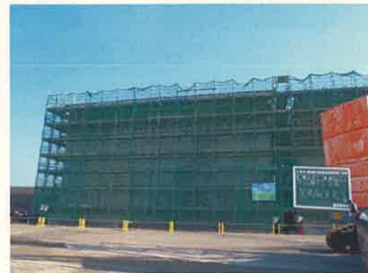
足場組立完了(安全ネット設置)
