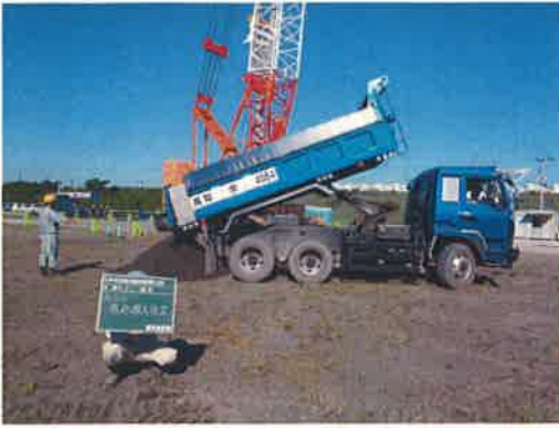
砂の運搬・仮置
