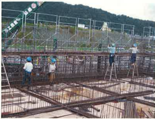
鉄筋組立状況(側壁)
