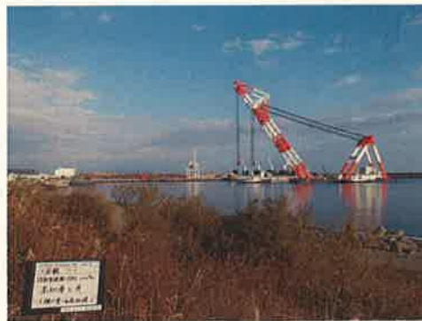
大型起重機船入港状況
