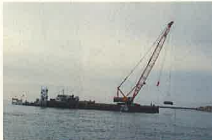
洗掘防止マット敷設
