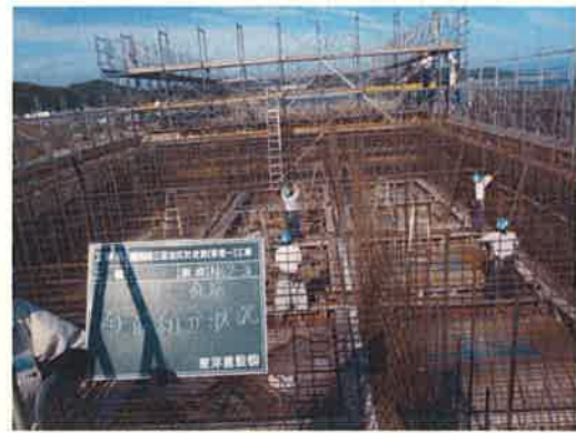
鉄筋組立状況(隔壁)
