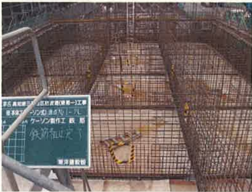
鉄筋組立完了
