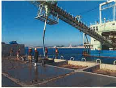
蓋コンクリート打設
