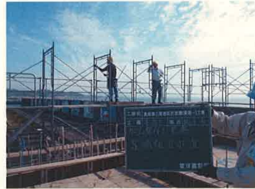
足場組立状況(2ロット目以上)
