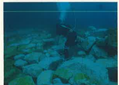
捨石均し(海中の状況)
