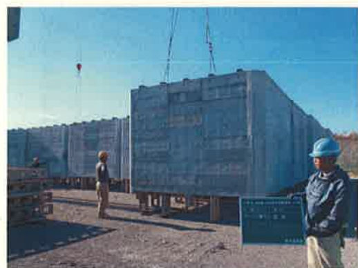
型枠大組状況(隔室用)
