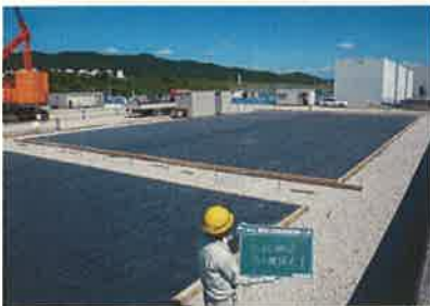
摩擦増大マット敷設
