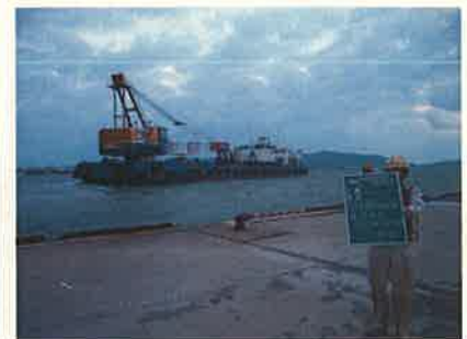
起重機船入港状況
