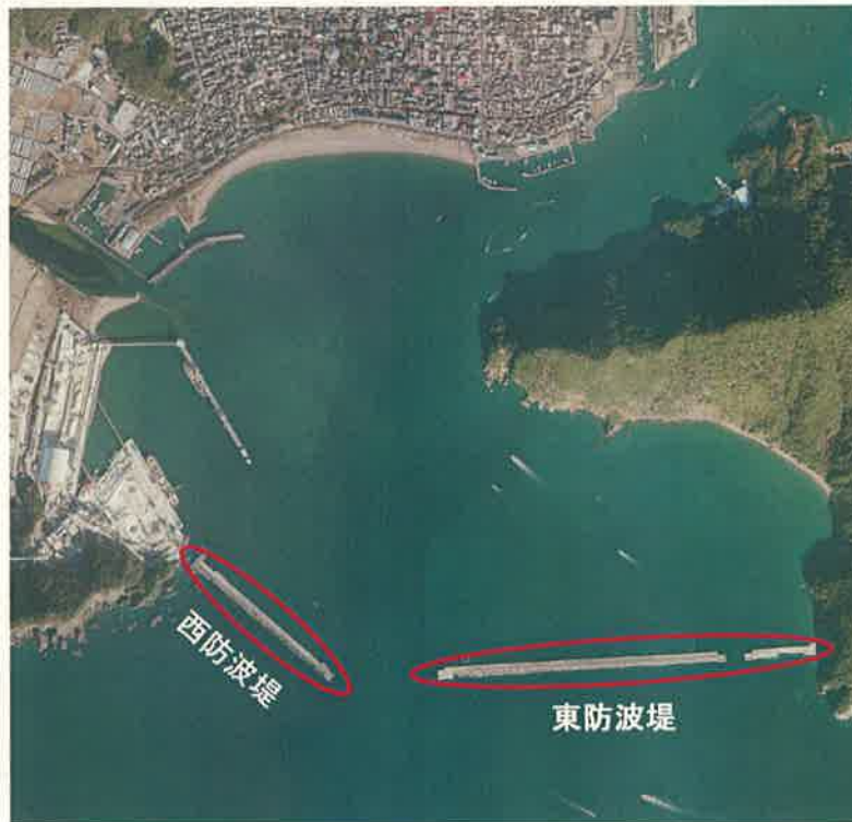
(東防波堤960m、西防波堤480m)
