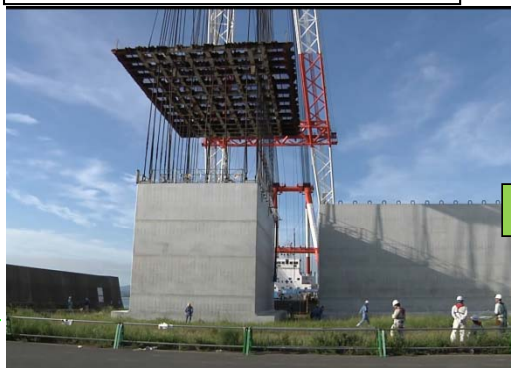
①作業足場設置・吊ワイヤ接続
