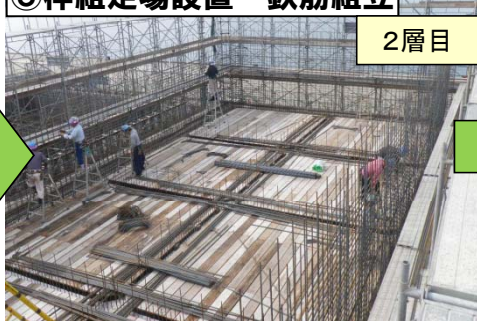
⑤枠組足場設置・鉄筋組立
