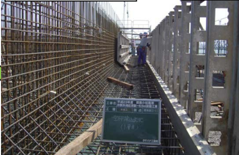
③型枠組立(外)
