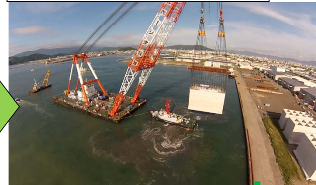
②ケーソン吊上げ・引出し・吊降し
