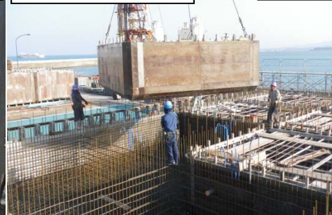
③型枠組立(内)
