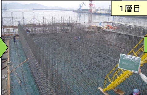
②枠組足場設置・鉄筋組立
