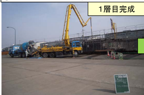
④コンクリート打設・養生・脱型
