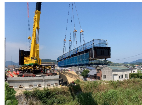
<本山小橋桁架設実施状況>
