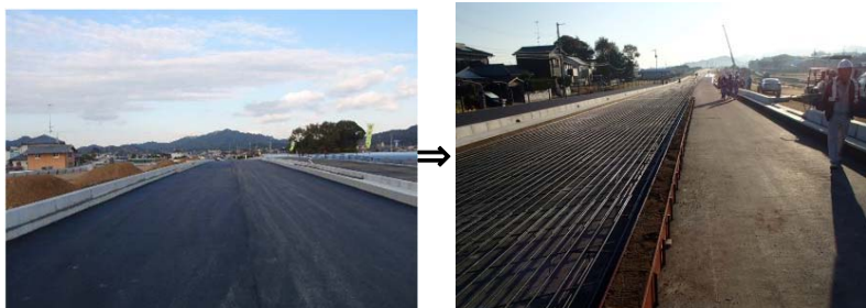
アスファルト中間層
