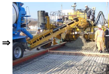
生コンクリート荷下ろし
