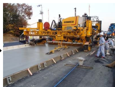
敷均・締固・平坦仕上げ (スリップフォームペーバ)
