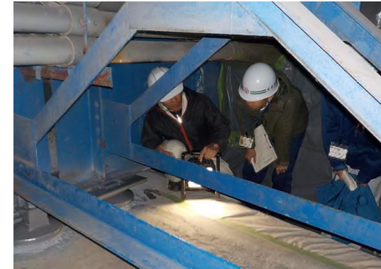
支承防錆工の施工状況見学
