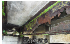
主桁の腐食
