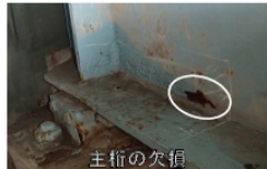
主桁の欠損
