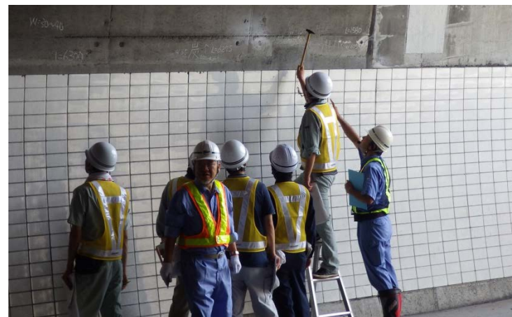
現地実習状況 (H28トンネル初級)
