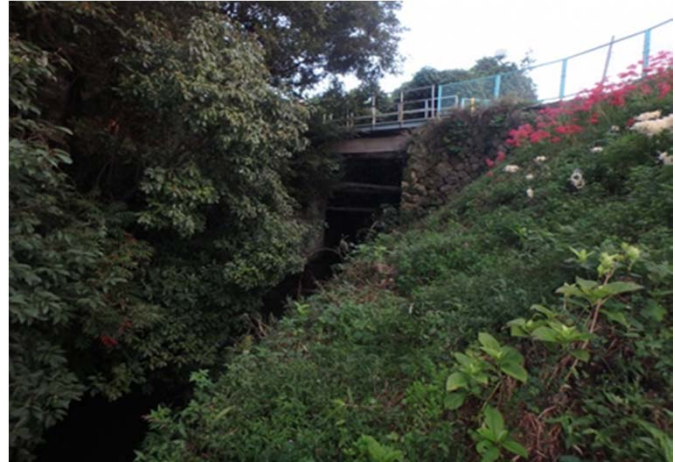
小作川5号橋全景
