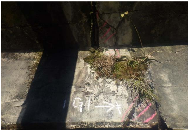
主桁のひびわれ
