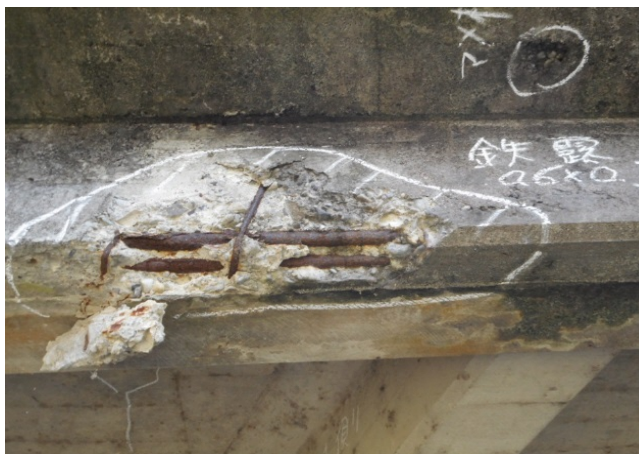
主桁の鉄筋露出
