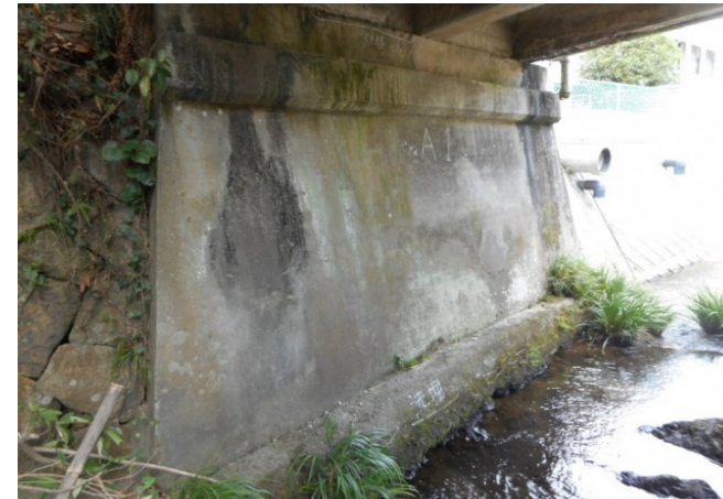
下部工の漏水・洗掘
