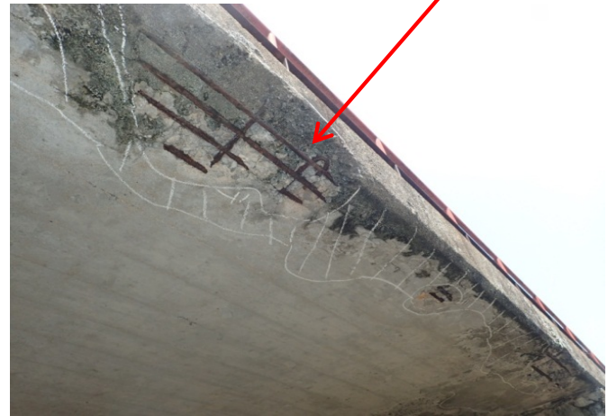
主桁の鉄筋腐食・欠損
