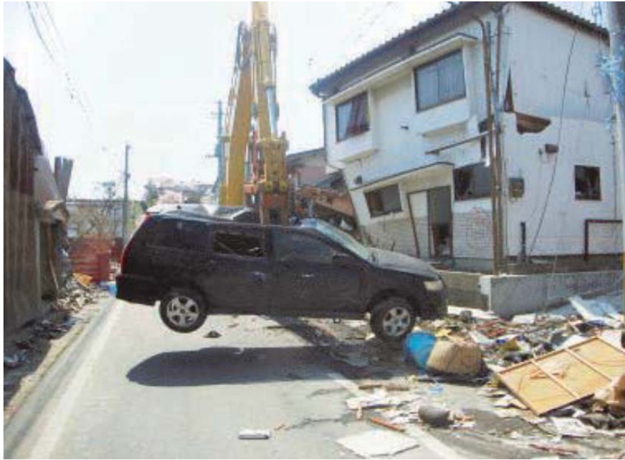
岩手県内における車両撤去の様子 出典：東日本大震災_現地レポート(東日本建設業保証株式会社)
