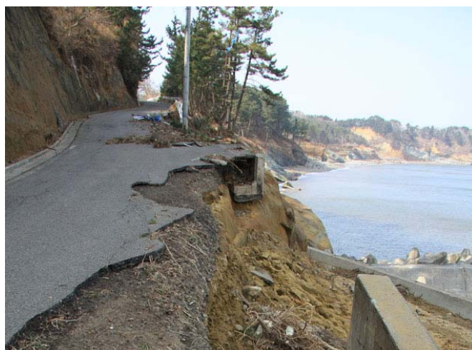
図 3-9 盛土法面崩落イメージ
