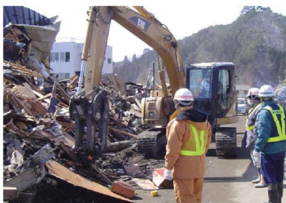
図 4-4 ガレキの撤去作業
