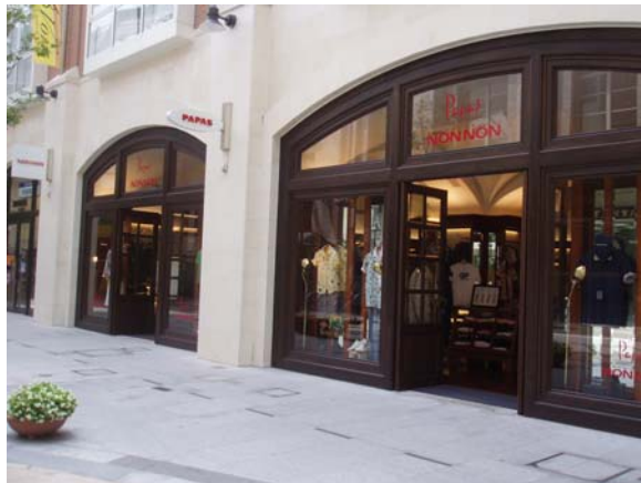
写真-6 高松丸亀町再開発ビルのファサード整備状況
