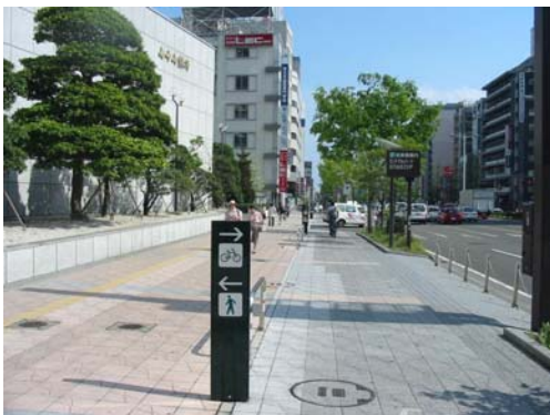
柵による分離の例(宮城県仙台市)
