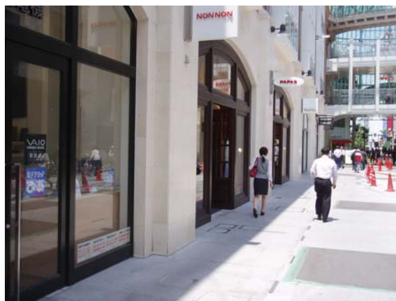
図-28 高松丸亀町再開発ビルのファサード整備状況
