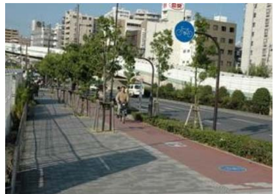
植栽帯による分離の例(大阪府大阪市)
