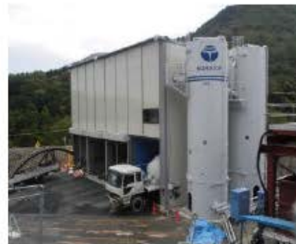
吹付けプラント
