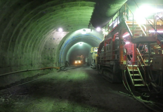
【トンネル内の状況】
