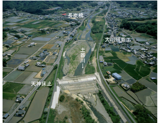
土器川中流部（天神床止付近）
