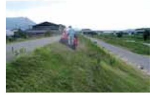
▲堤防除草状況
