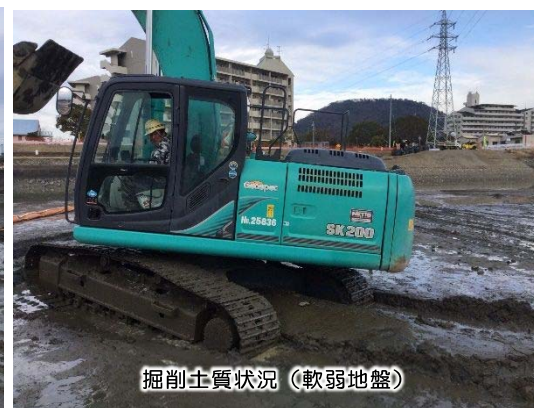
軟弱地盤の河道掘削の状況
