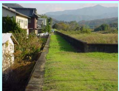
大川頭首工上流の右岸堤防状況
