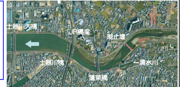
下流部の河道湾曲状況
