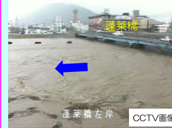
HWL相当まで水位上昇 (1.6k付近)
