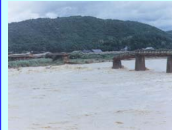
旧乙井橋流出 (11.6k付近)
