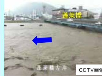
HWL相当まで水位上昇 （1.6k付近）
