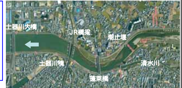
下流部の河道湾曲状況
