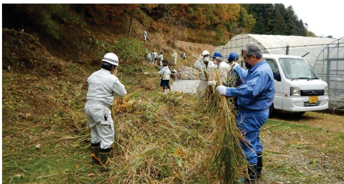
リサイクル活用可能な材料の分別作業
