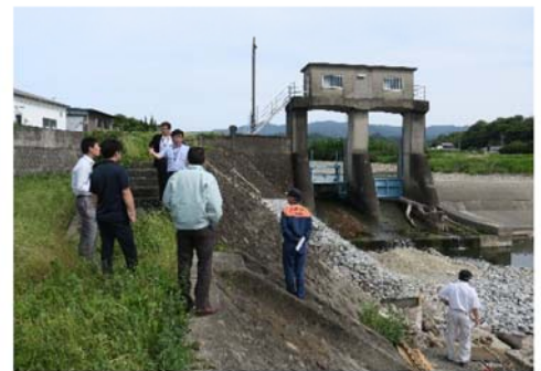
重要水防箇所の巡視 (右岸16k/6:堤防高不足)
