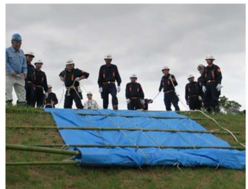
水防の基本となるロープワーク 越水防止の「改良積み土のう工」を体験 堤防侵食防止の「シート張り工」を体験
