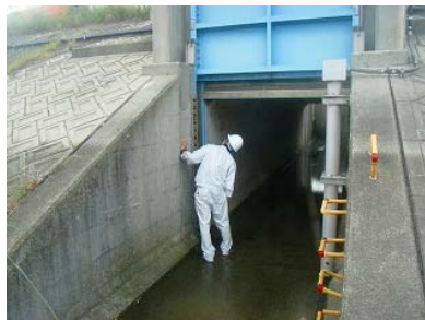
樋門巡視状況
