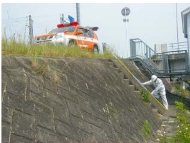
護岸巡視状況
