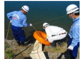
排水ポンプホース設置状況
