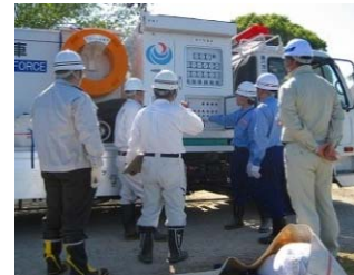
排水ポンプ車操作説明
