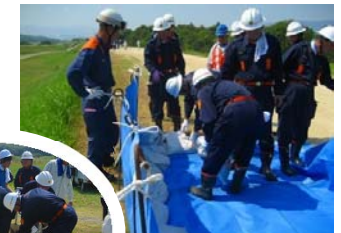
水防工法(改良積み土のう工)
