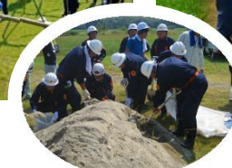
準備工(土のう作り)
