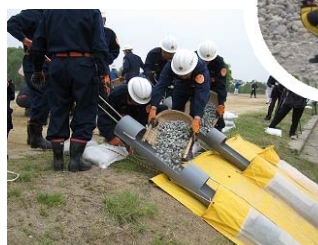
水防工法(水防マット工)
