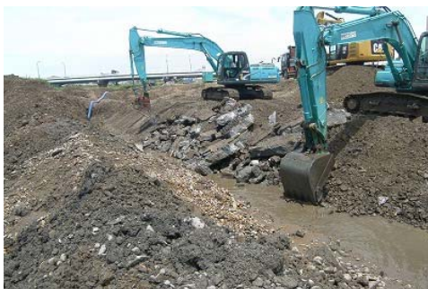
①高水敷掘削
