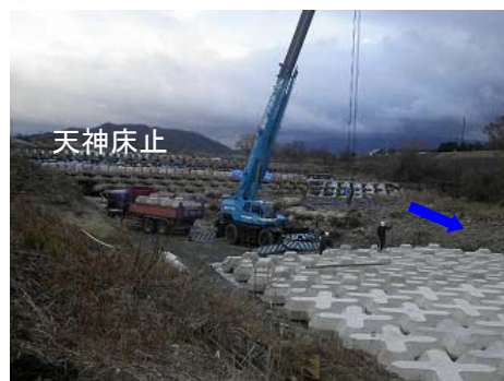
施工状況(根固めブロック据付)
