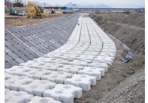
「護岸工・根固工」施工状況
