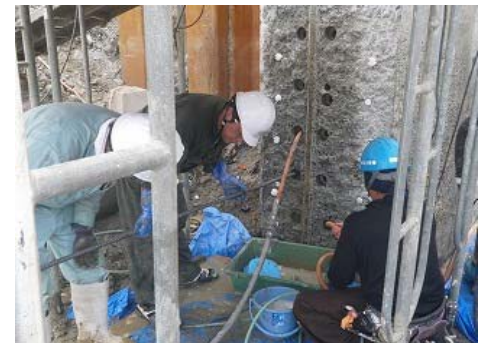
「鉄筋挿入工」施工状況
