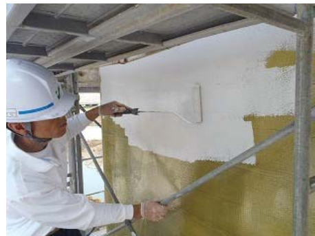
「繊維シート塗装」施工状況
