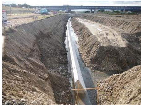
「護岸基礎工」施工状況
