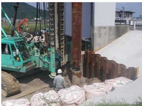
「鋼管杭」施工状況
