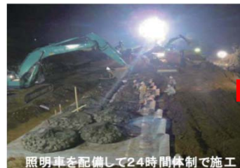
小堤約100mの決壊箇所への応急復旧工事
