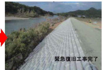
小堤約100mの決壊箇所への応急復旧工事
