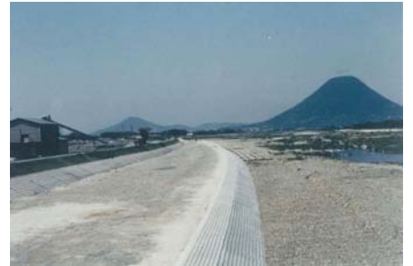
昭和57年築堤直後の垂水地区
