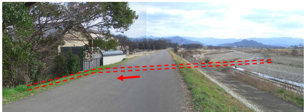
板谷出水(河口より6.6k右岸)下流側から撮影
